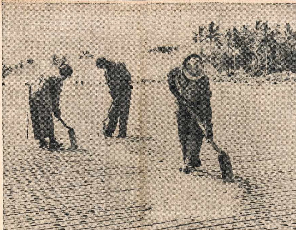
Kur nors Pacifike prireikė Yankiams aerodromo. Tai Dėdės Samo inžinieriai per 18 dienų ir prirengė. Vaizdas parodo, kaip didelė lyguma apdengta metaliniu tinklu, kurio skylėse pripilama coralų medžiagų.
