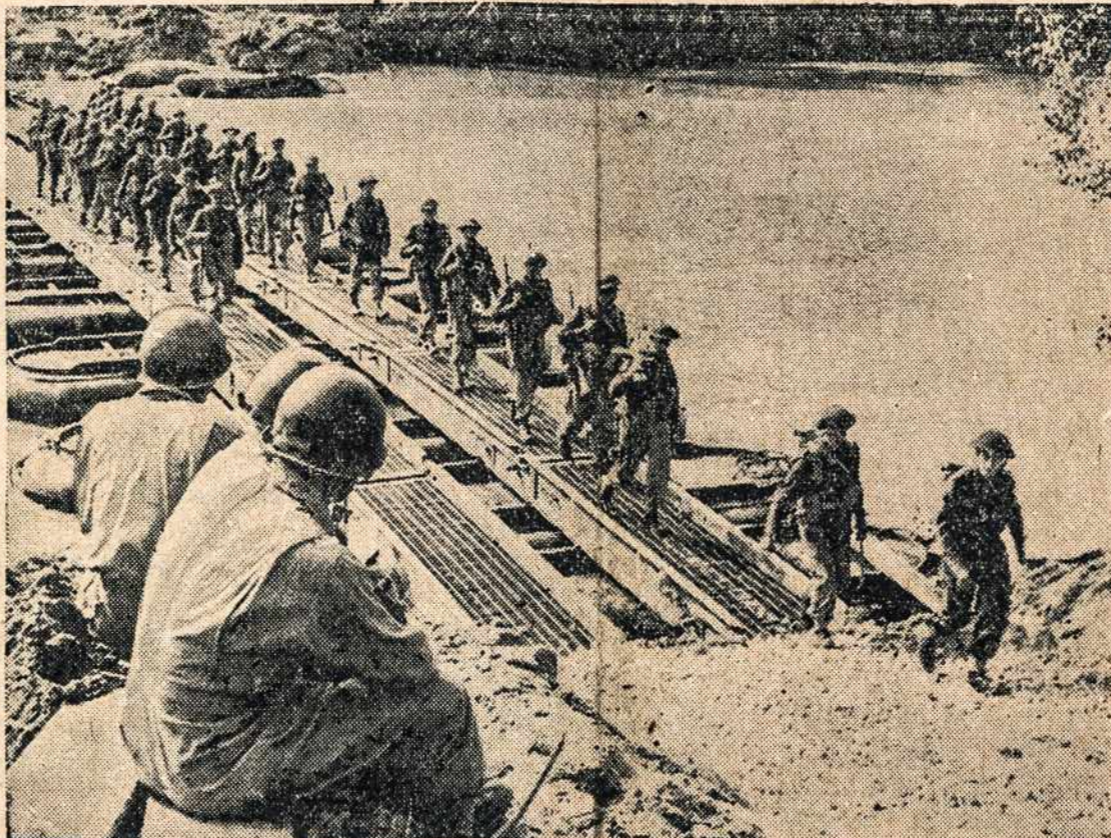
Britų Aštuntosios Armijos kariuomenė pereina pantono tiltu, kurį pratiesė amerikiečiai kariai - inžinieriai per Voltorno upę, Italijoje. Naciai kanuolių ugnimi bandė sutrukdyti inžinierių - karių darbą, bet vel-tui, nes patiems reikėjo trauktis.
