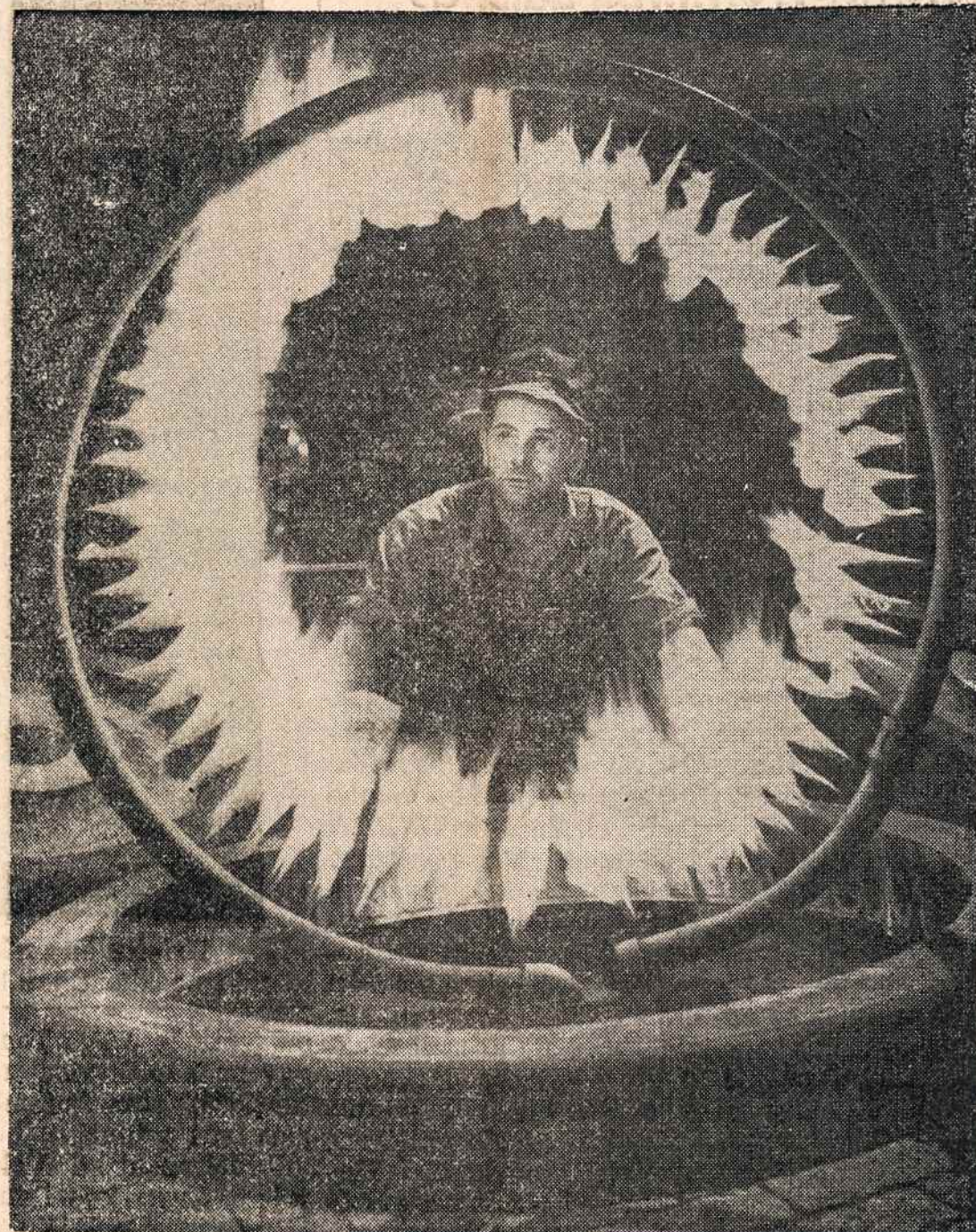
Liepsnų žiedas — General Electric įstaigos, Erie, Pa., darbininkas išbando gaso žiedą, kuris vartojamas susildymui diesel-elektrikinių ir elek- trikinių ratų lokomotyvams pirm uždėjimo plieninių padangų.
