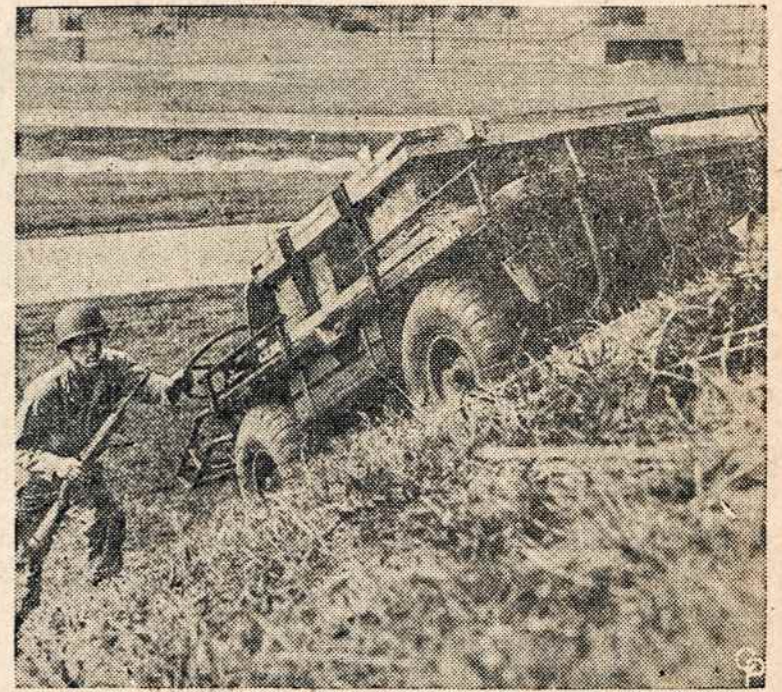
MECHANINIS kariuomenės "mulas", sverias tik 750 svaru, buvo išbandytas Aberdeen, Md., bandymo laukuose. Jis gali vežti pasc-tonos medžiagą. Jį galima vairuoti, vesti kaip arkį arba vedžioti viena ranka.
