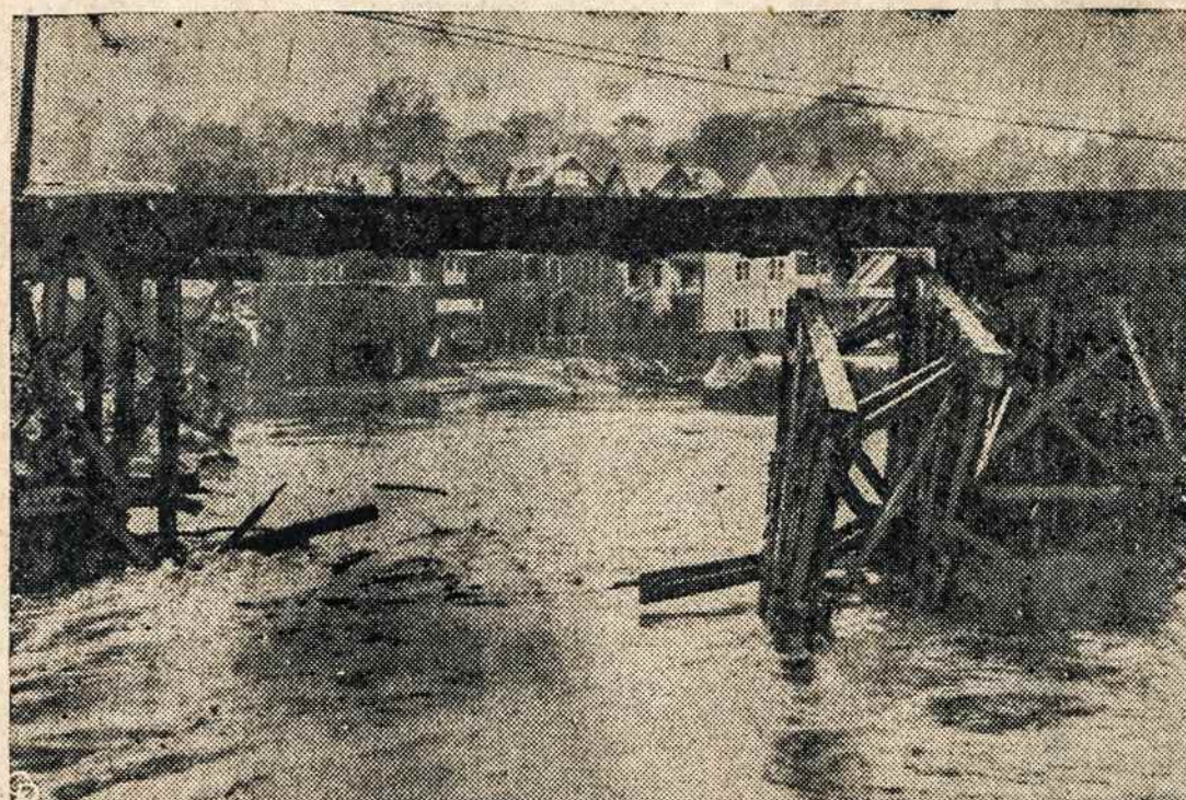
WATERBURY TILTAS, kuris buvo laikinai pastatytas per Naugatucko upelį po Diane uragano. Tik tris dienas jis buvo atidarytas, ir dabar vėl Naugatuckas jį nuvertė.
