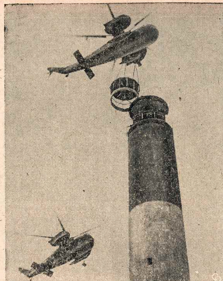
HELIKOPTERIAI padeda stati jūros švyturį Oak Island N. C. švyturys turės 2 milijonus žvakių stiprumo šviesą ir jį bus montoma už 25 mylių.
