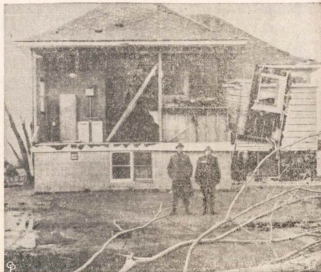
Tornado Wisconsin valstybėje nusinėšė 27 gyvybes. Čia matome Colfaxe apgriautą mokyklą.
