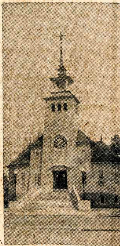
EAST ST. LOUIS Lietuvių parapijos bažnyčia, architektūra J. Muloko.
