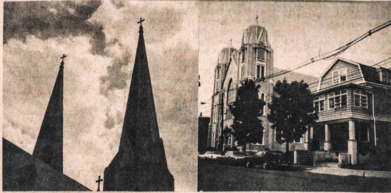
Elizabetho Šv. Petro ir Povilo bažnyčios bokštai turėjo būti nuimti ir pakeisti. Kairėje — taip dar neseniai atrodė bažnyčios bokštai, kurie pravažiuojantiems pro šalį buvo lyg koks kelrodis. Dešinėje — taip dabar atrodo po remonto bažnyčios bokštai.
