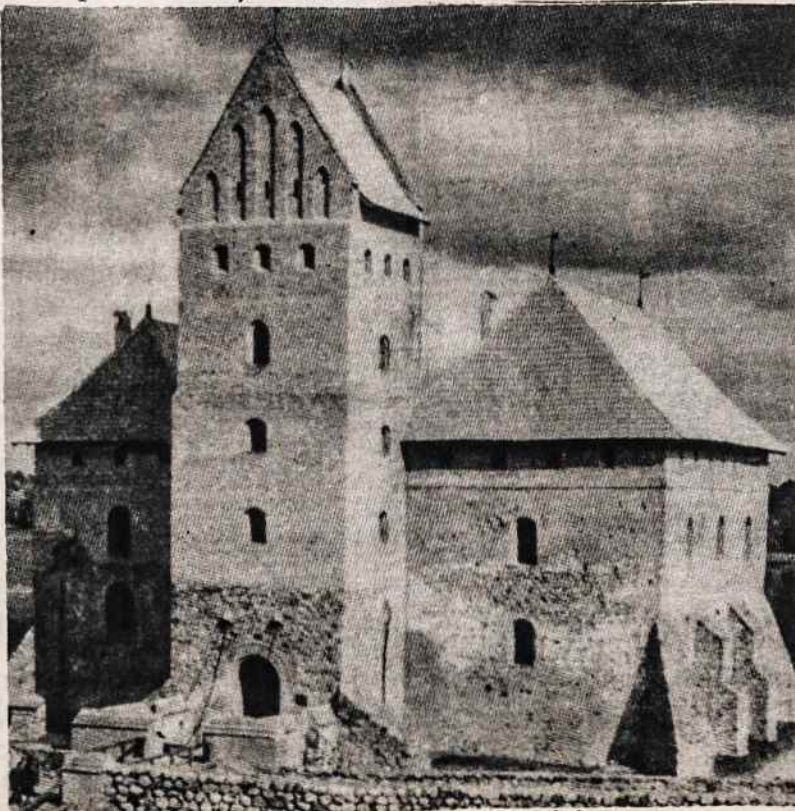
Atstatytos Trakų pilies centrinis gynybos bokštas ir gyvenamieji kambariai, salės.
