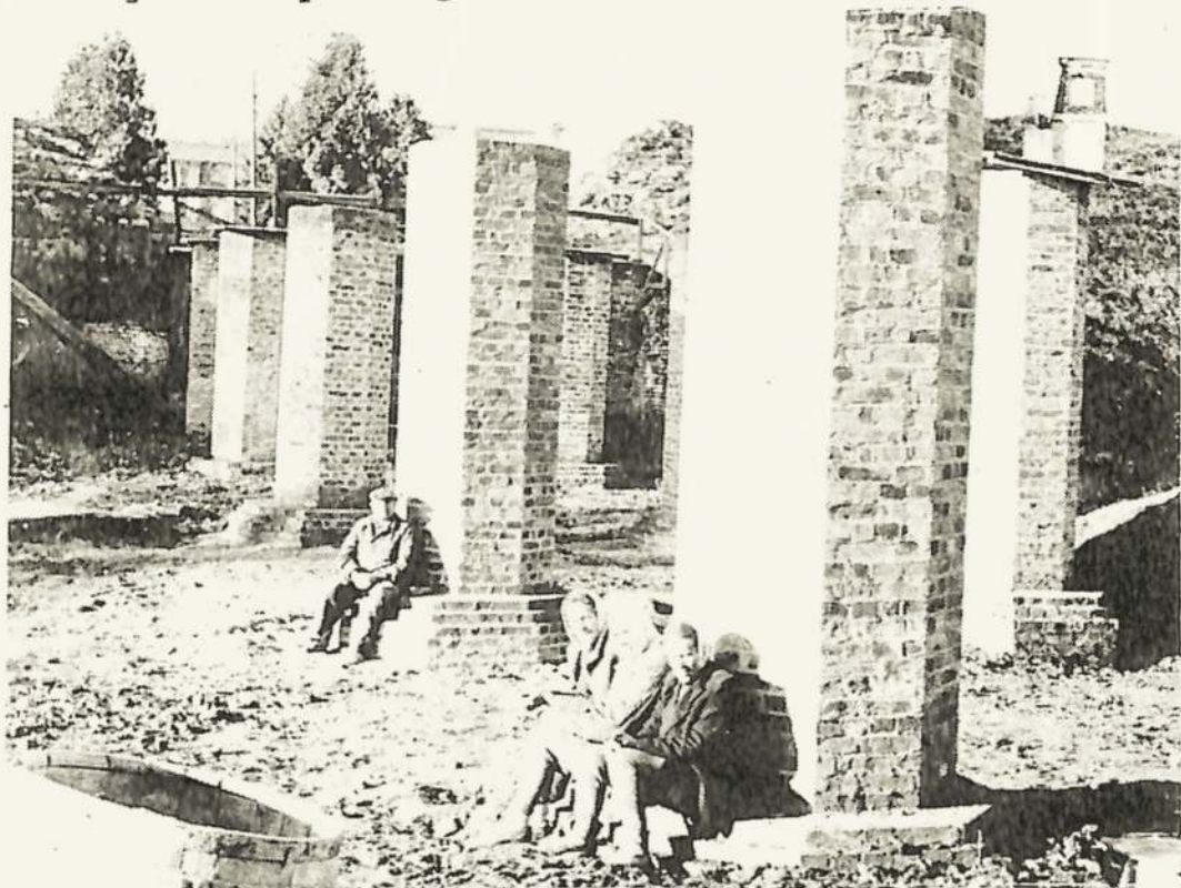
Atstatyto tilto į Biržų Radvilų pilį poliai pamūryti ant tų pačių buv. pamatų.
