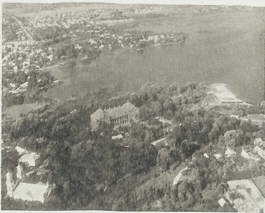
Restauruotos Biržų pilies vaizdas iš lėktuvo.
