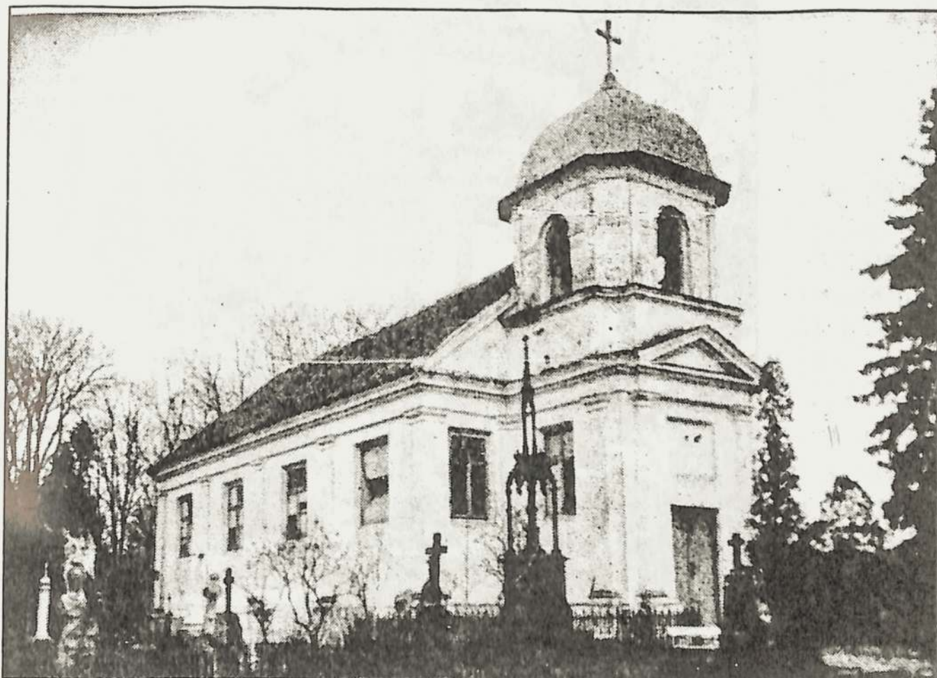
Buvusi ev angeliku reformatų kapinių koplyčia K. Kalinausko g.21
