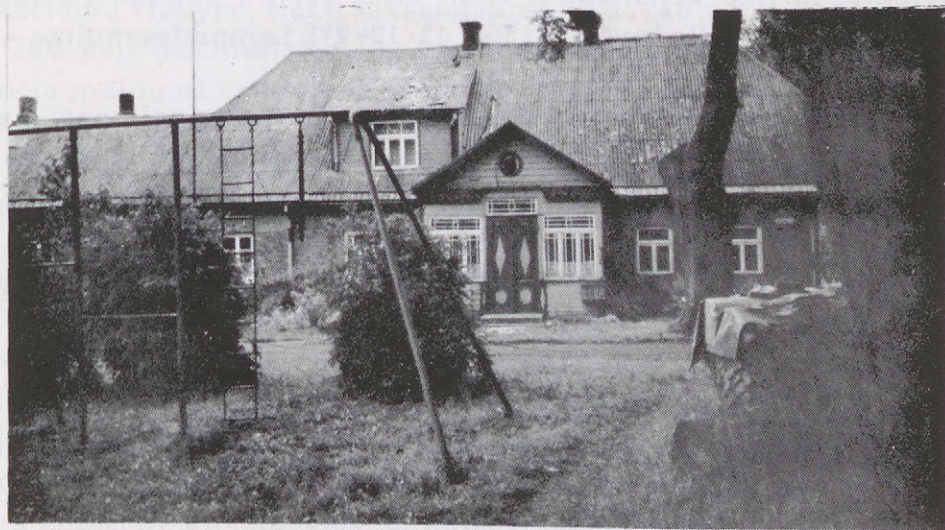
Biržų Ev. Reformatų klebonija
