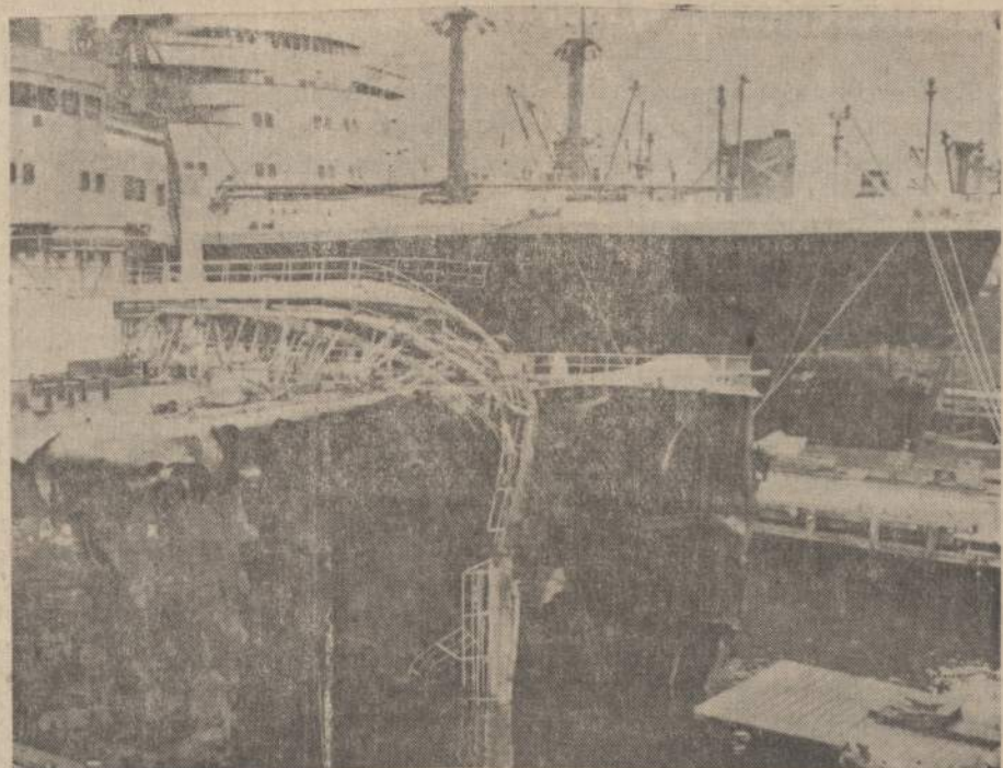
30,000 tonų Amerikos laivas Constitution ir norvegų tanklaivis Jalanta laukia remonto Brooklyn, N. Y., laivų doko po susidūrimo. Penktas mylias už New Yorko atvirą jūrą tieku laivai tirtoje migloje susidūrė; laivui Constitution išplėsta šone 50 pėdų ilgumo skylė, o Jalantai atplėtas galas.
