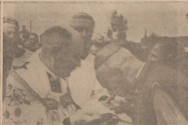
Kunigas Ljudas Pavilonis, marionų vienuolis, 1957 m. birželio mėn. 30 d. sutinka vyskupą P. Maželį Klaipėdoje, atvykusi šventinti pamatus naujai statomas Taikos Karalienės bažnyčios.
