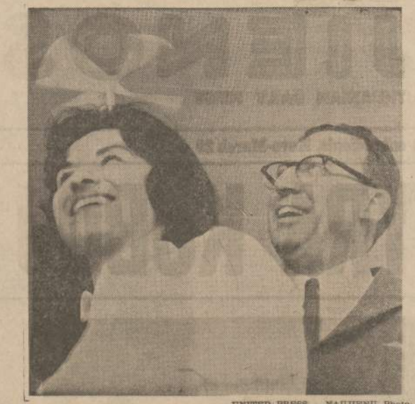
UNITED PRESS - NAUJIENŲ PHOTO Mrs. Nancy Rogers kūno šiluma suka ant jos galvos pritaistytą propelelį. Tai yra Michigano universiteto profesorius Gerald C. Gill išrastas nepaprastai jautrus anemometras, kuris gali matuoti oro srovės net mylios ketvirtadaliu per valandą greitį. Iki šiol mažiausias išmatuojamas greitis buvo 2-3 mylios per valandą. Prof. Gill sako, kad stiprus, vienmarškinis vėjo kūno šiluma pagamina aukštyn kiliančią šiltą srovę nuo 1/4 iki 1/2 mylios per valandą greičiu.
