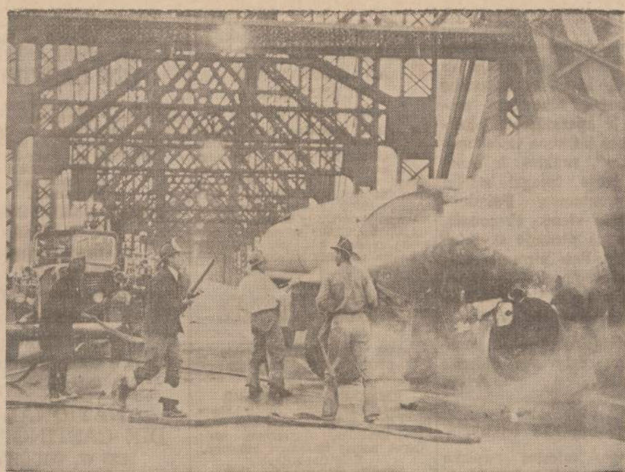
Važiuojant per St. Louis (Mo.) miesto tiltą sprogo padanga. Sunkvežimis atsimušė į tilto užtvarą ir užsidegė. Ugniagesiai bando gaisrą užgesinti.
