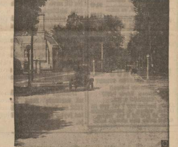
Cementinės gatvės iš 1920 metų laiku dar ir šiandien tebėra geria formoje, kad ir po 40 metų daugelyje Iliinojaus miestelių. Valdo matoma viena seniausių cemento grista gatvė Urbanoje, Ill. Portland Cement Association renka žinias apie tebeegzistuojančias cementines gatves ir tada skiria premijas už geriausiai išsilikusias gatves.
