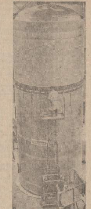
Milžiniškas fibrinio stiklo dangtis užvožiamas ant raketinio motoro ir sujungiamas su apatine dalimi. Viskas atrodo panašu į stiklinį bokštą.
