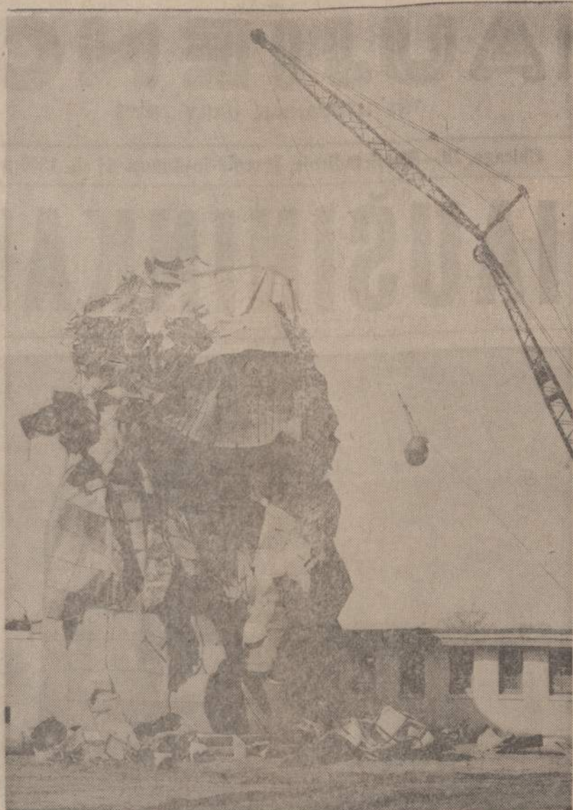
Griovėjams teko sunkiai dirbti, kol nuvertė plieno ir mūro silo, pastatytą žiemos pašarui ruošti. Paveikslo matome iškeltą plieno rutulį, kertantį į silo šoną.
