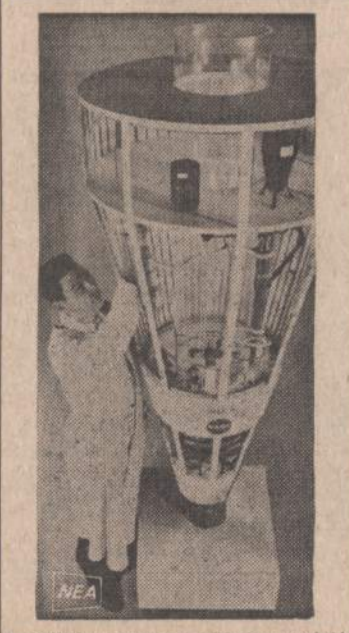
Paveiksle matomas prietaisas eldvėje galės pagaminti 35 kilovatus elektros energijos. Dabar jis yra bandomas Kalifornijoje, Azusa srityje, kad galėtų tiksliai nustatyti, kiek jis bus naudingas astronautams ir erdvės tyrinėtojams.
