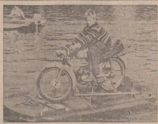
Jaunas olandas, negalėdamas kanalais važinėti motociklu, pritaikė motociklą prie savo plūdes. Motociklo jėgos ratas suka plūdės sraigtus, o kojomis jis gali plūdę valdyti.
