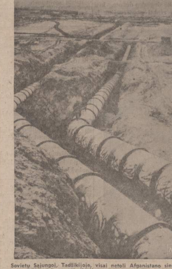
Sovietų Sąjungai, Tadžikijoje, visai netoli Afganistano sienos, sovietų inžinieriai pravedė didelius vandens vamzdžius vandeniu siųsti į saus dirvožemius. Vandens vamzdžiai pravedti upokšnių vagose.
