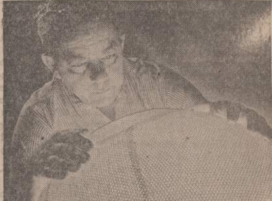
Ant didžiųjų Amerikos bombonešių uodegų yra radaro įtaisai. Jie apdengti paveiksle matomu plastinės medžiagos bokšteliais. Bokštelių apžiūrėja aviacijos technikas.
