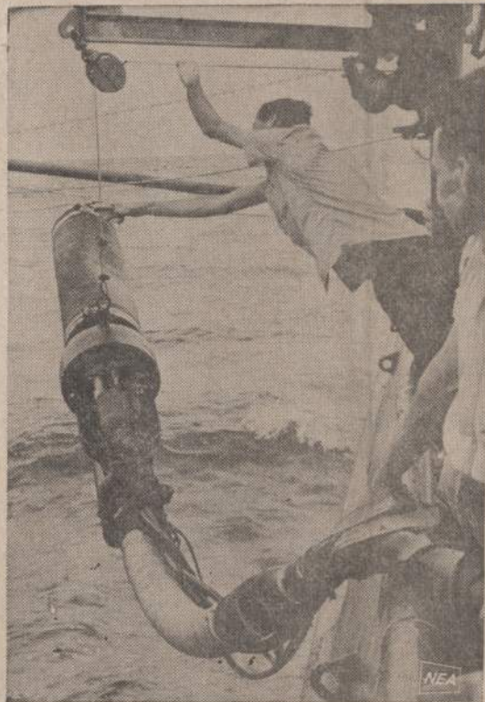
Leidžia į jūros dugną prietaisą, kuris praneša jūros dugno sudėtį. Dugne atsistojes prietaisas leidžia į visas puses radijo bangas, kurios atfoka ir atsimuša į laive esančią specialią anteną. Sugrįžusios bangos pasako, ar dugne yra granitas, molis, dumblias, geležis, aliejus ar kita medžiaga. Radijo bangos taip pat pasako, kokio storio jūros dugno klodai yra. Specialistai greičia jūros dugną toje vietoje, kur aliejaus versmė yra arčiausia.
