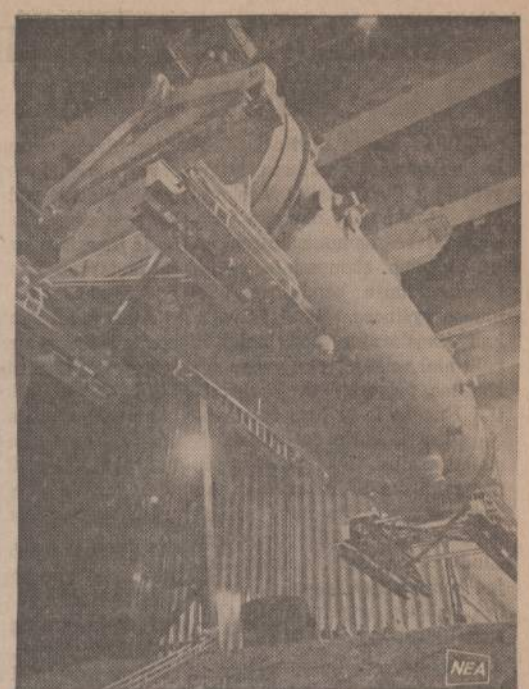
Atomo laikų katilas, galįs į sekundę užvirsti vieną toną vandens. Netoli Chicagos Babcock & Wilson bendrovė stato atomo energijai varomą elektros stotį Dresdno apylinkė.
