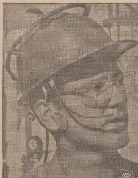
Nauja stovybos darbininkų kepurė turi specialų žiedą, kuris duoda progos darbininkams girdėti radio pranešimus. Trisdešimtmame aukšte dirbantis darbininkas užgirs ant žemės esančio prižiūrėjojo įsakymą, kas toliau daryti ir kurį darbą pirma baigti.
