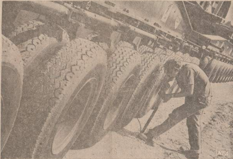
Prie Greenville, S. C. statoma nauja atominė jėgainė. Jai reikalingas generatorius buvo pagamintas Babcock ir Wilcox bendrovės, kuri turėjo pastatyti ir specialią platformą generatoriui pervežti. Platforma turi 240 ratų, ją stumia du motorai po 600 arklio jėgų. Pats generatorius sveria 570 tonų.
