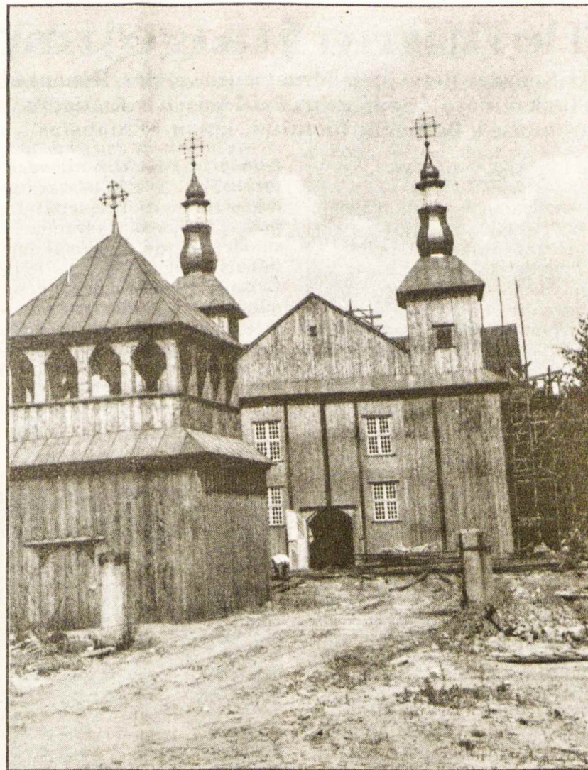
Restauruojamas architektūrinis paminklas – Šv. Juozapo šventovė ir varpinė Kėdainiuose. Nuotr. A. Suprono
